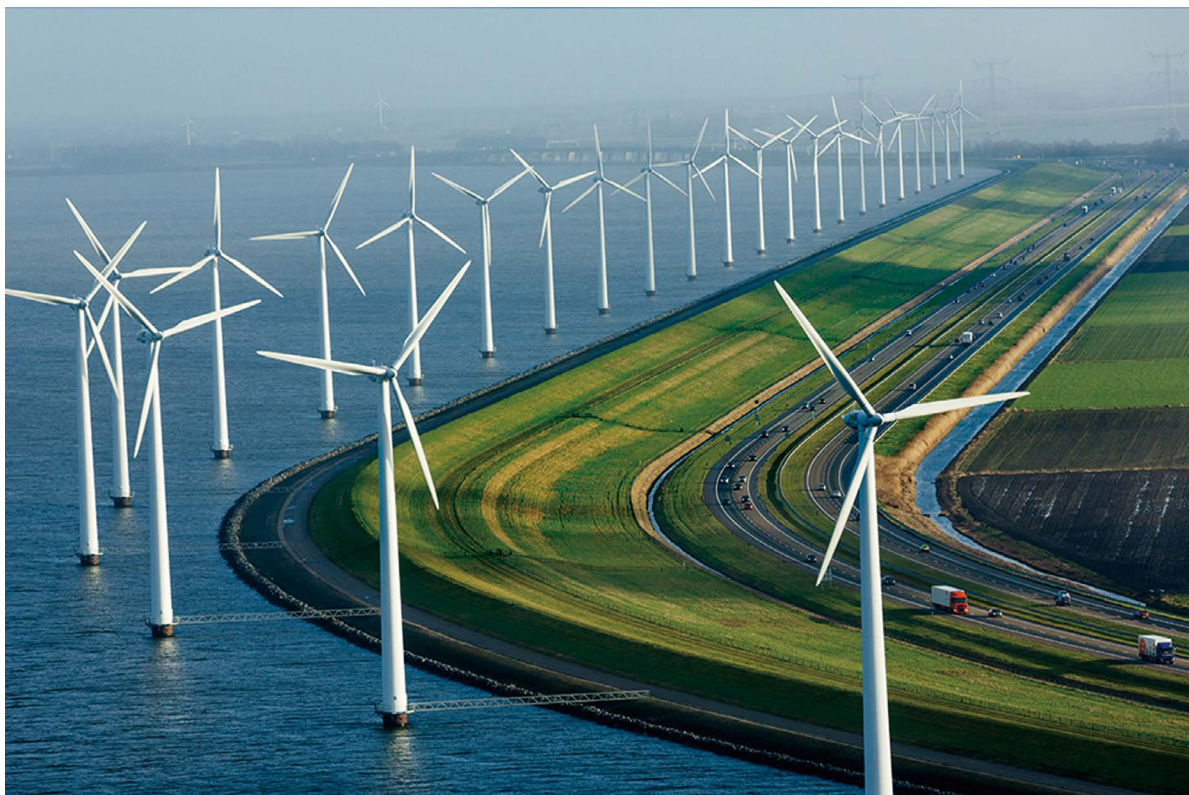
▲ 海平面上升 摄影: George Steinmetz 这道沿线有风力涡轮机相伴的大坝保护着几乎全盘低于海平面的农田。堤坝和持续不断的泵水作业保证了该国至少四分之一的土地不致退化为沼泽或开阔水域。
